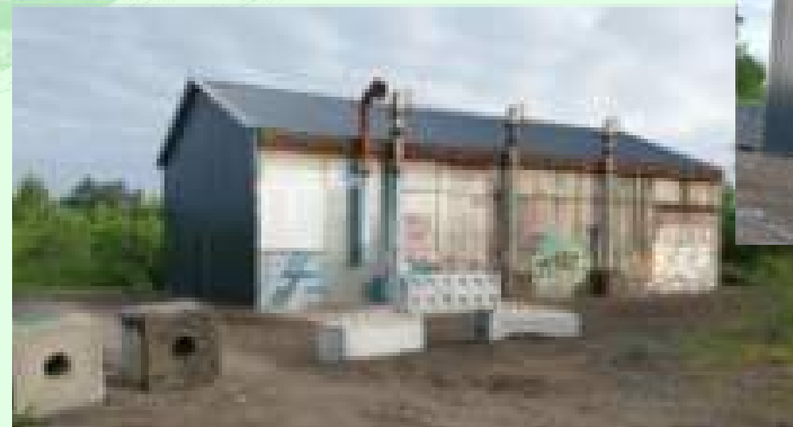
Salle des compresseurs récemment sécurisé ALM 2025
