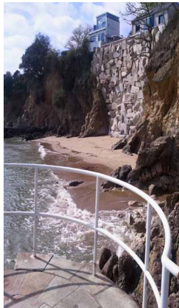
↑ Mur cyclopéen pour tenir le chemin.
