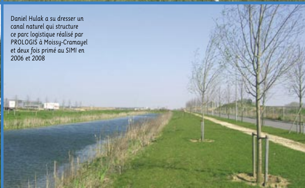
Les noues engazonnées de prairies fleuries sont capables d'absorber et de guider une grande quantité d'eau.
