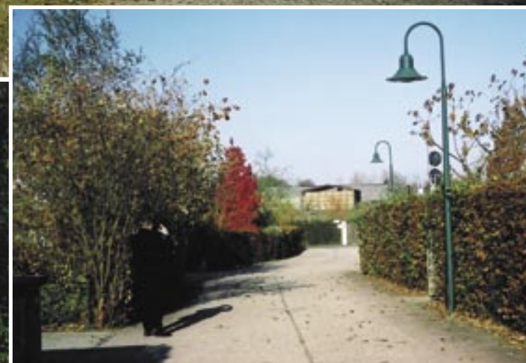
4,50 mètres pour cette voirie mixte en béton
