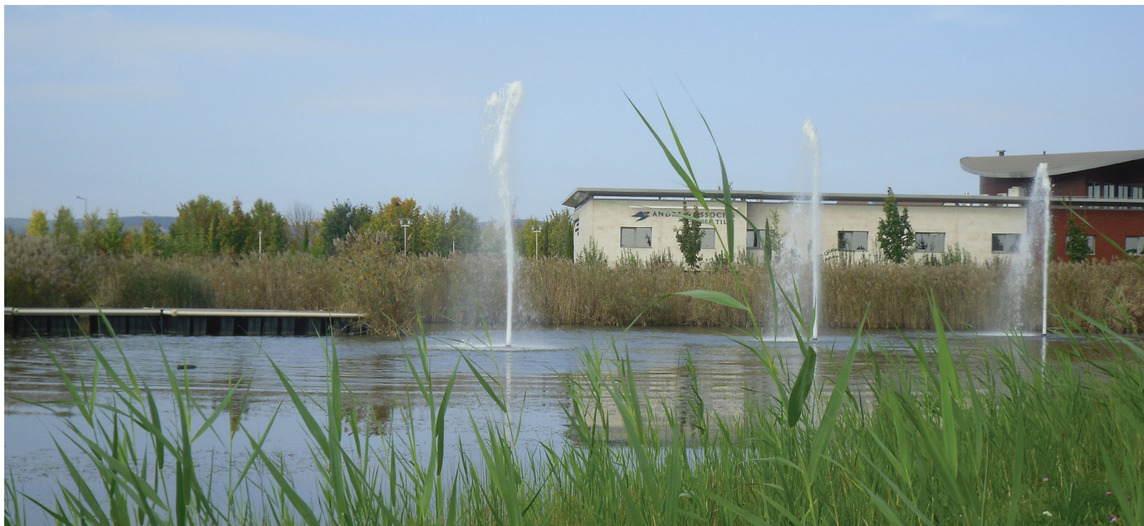
Bassin de recueil des eaux pluviales à Beaune (21) transformé en bassin d'agrément et d'auto épuration
