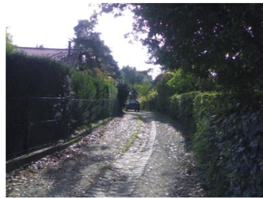
↑ Caniveau d'écoulement des eaux pluviales devant le parc aux daims
