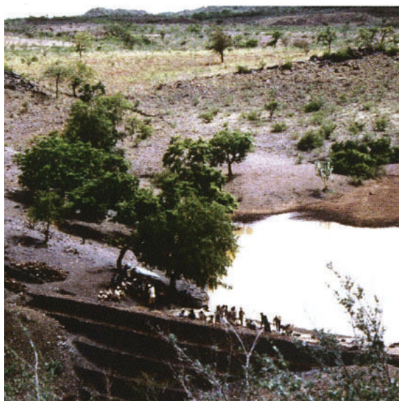
Élévation du barrage avant la saison des pluies
