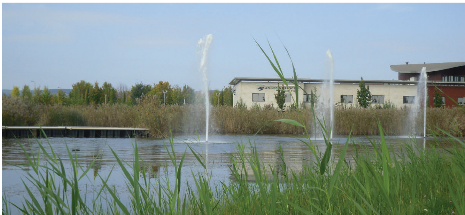
Bassin de recueil des eaux pluviales à Beaune (21) transformé en bassin d'agrément et d'auto épuration
