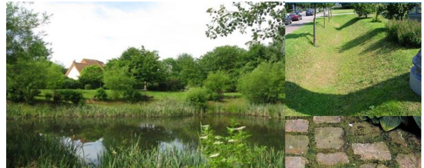
^ Une section aménagée des eaux pluviales
